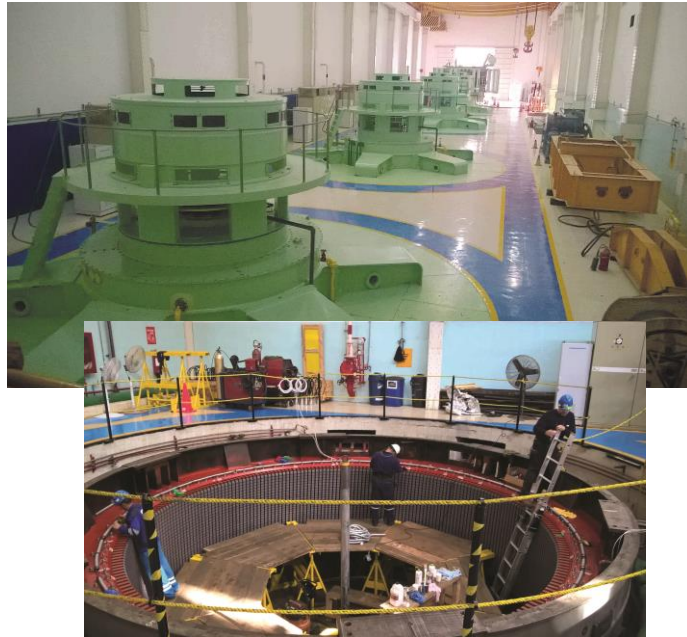
Temascal / Mexico (4x 38.5 MW) Full-scale EM rehab
