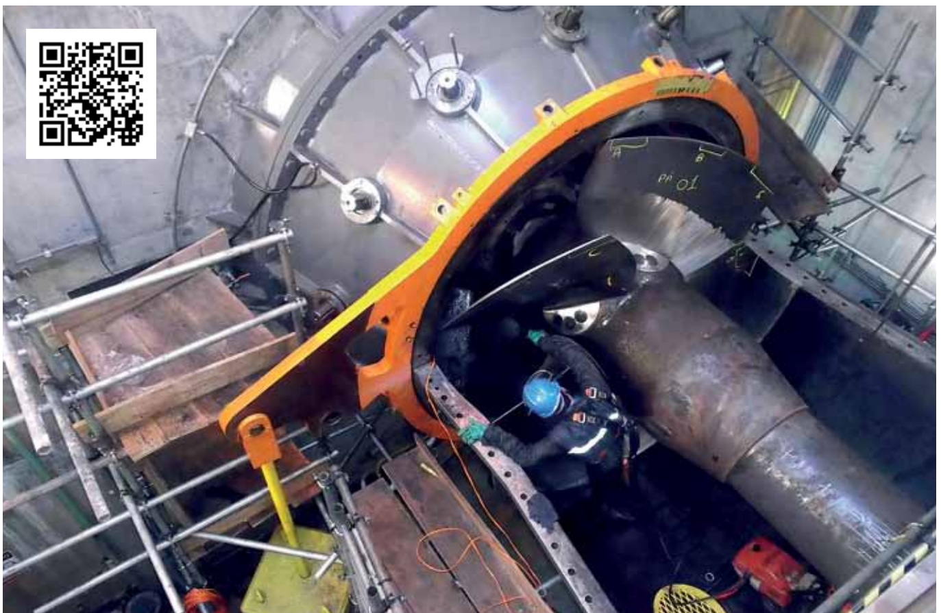
▼ Service sur une roue Kaplan du projet de Mogi Guaçu
