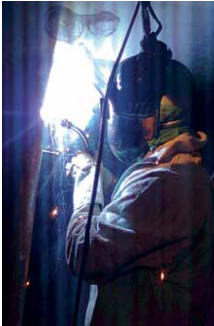
▲ Service de réparation de cavitation dans la centrale hydroélectrique de Taquaruçu
