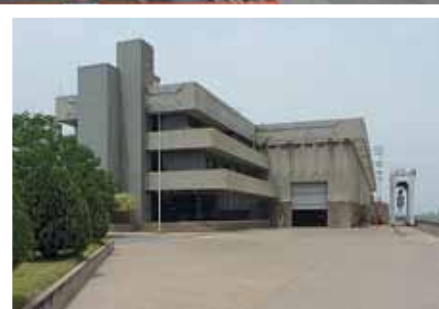
▲ La centrale hydroélectrique de Kpong
