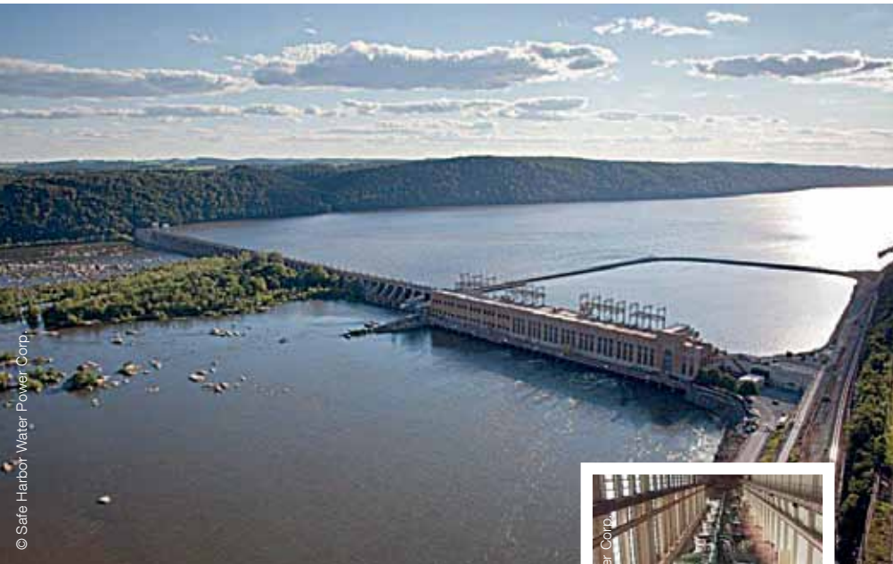
▲ Vue aérienne de la centrale hydroélectrique
