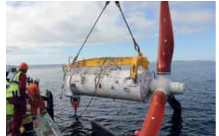
▲ Installation sur le site d'EMEC
