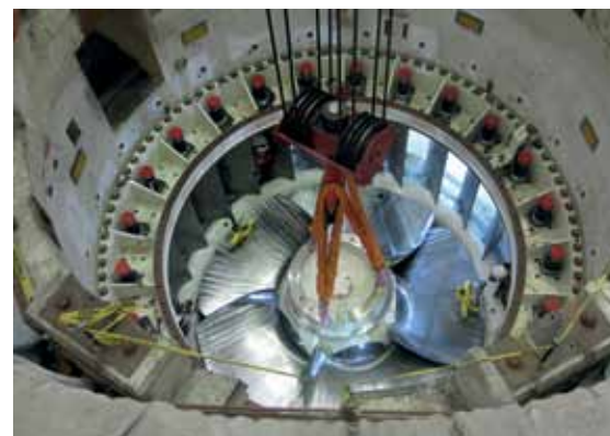
▲ Levage de la roue
