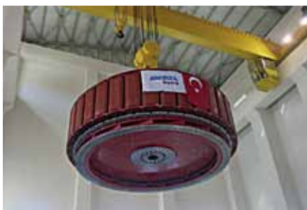
▼ Levage du rotor de l'unité 2
