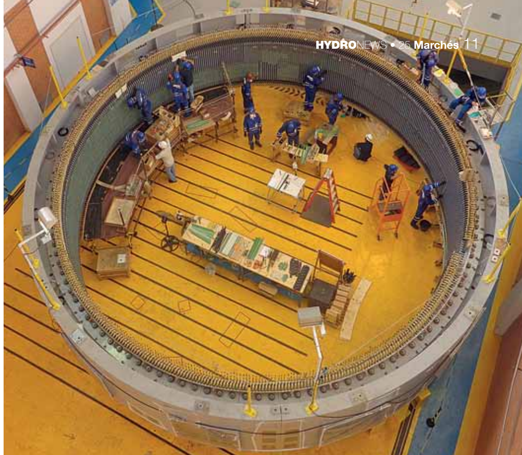
▲ Assemblage de l'enroulement dans la centrale hydroélectrique de Cachoeira Dourada
