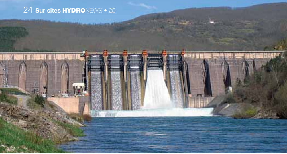
▲ Vue de la centrale hydroélectrique de Bajina Bašta
